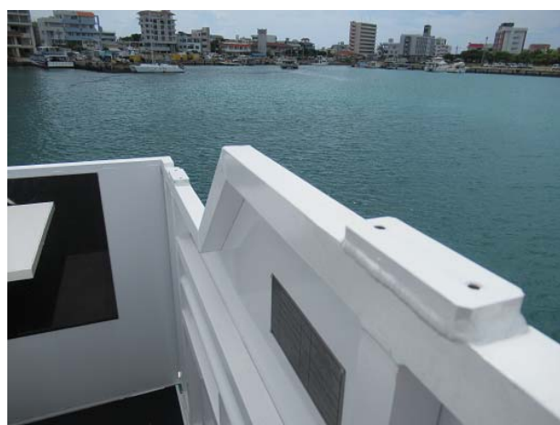
将来的には屋根を設置予定
