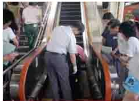
車いす対応エスカレーター
