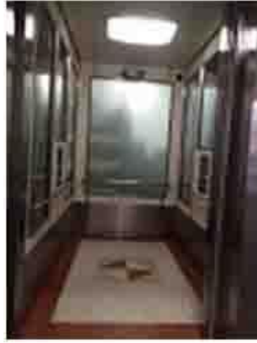
袖壁のない20人定員のエレベーター かがり内の設備（シースルー・凸面鏡・両サイドの操作ボタン）
