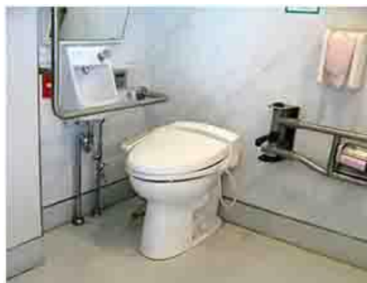
ベイシャトル船の多目的トイレ 大型電動車いすも転回できるスペースがある
