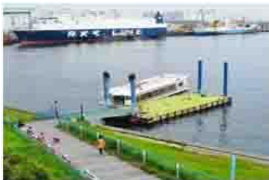
桟橋まで14段の階段があり、車いすでの利用が不可能（パレットタウン桟橋）
