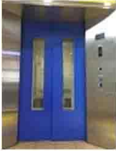
袖壁のない20人定員のエレベーター かがり内の設備（シースルー・凸面鏡・両サイドの操作ボタン）
